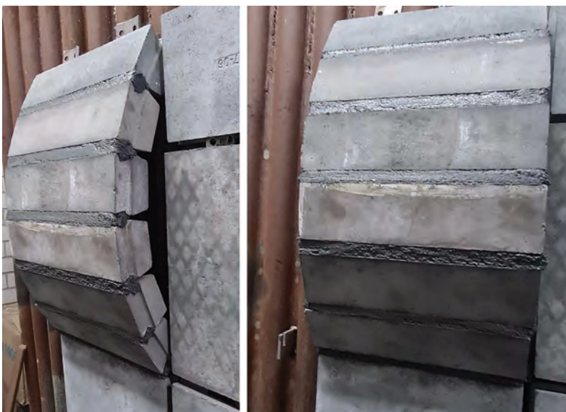
Abb. 13: Mock-up an der Probewand
