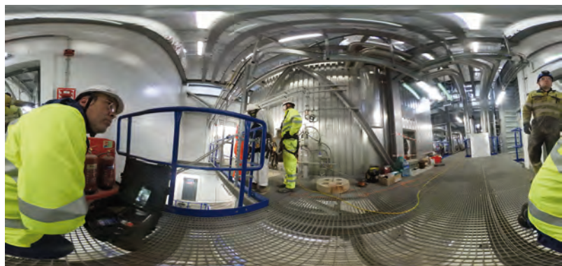
Abb. 2: 360°-Inspektion eines Müllkessels vor der Reinigung zur Freigabe
