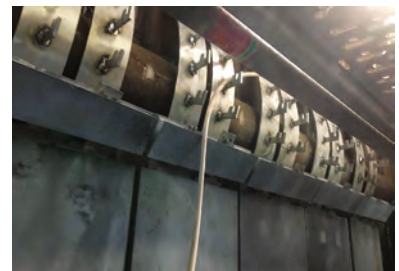
Abb. 14: Beankerung und Montage der Haltebügel
