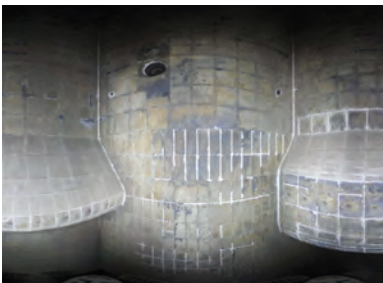
Abb. 3: 360°-Blick auf hinterlüftete Zündeckennase und Einschnürung
