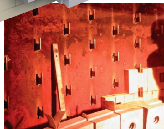
JuSys ®CFB adiatat Ankerbefestigung u. Isolierung
