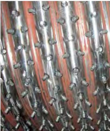
Bild 2: Kesselstiftverankerung
