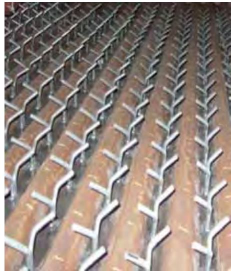
Bild 3: 3-D Rundstahlanker
